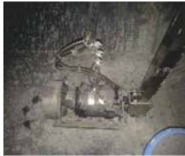
현장 교반기 설치 사진(회전식 가이드바)
