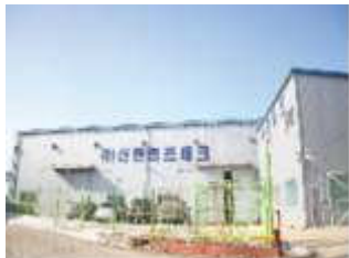
공장 외부 전경
